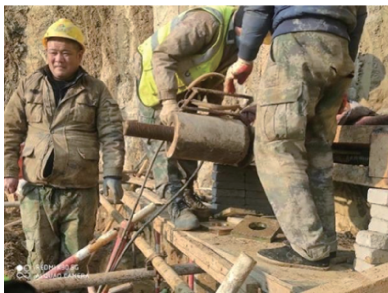
(c) 安装张拉设备
