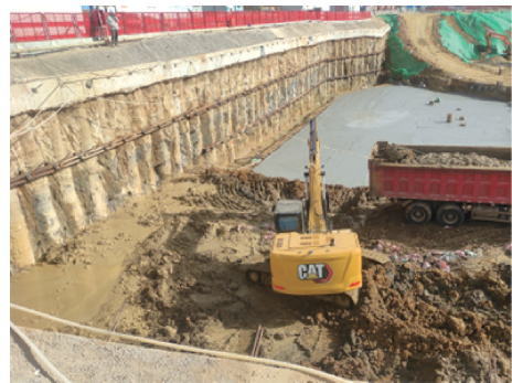
图 1 基坑支护照片
