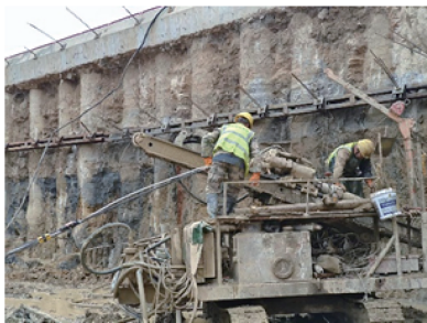
(b) 安装锚索并注浆
