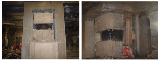
(a) “抱柱托梁加垫” (b) 静力切割框架柱混凝土
